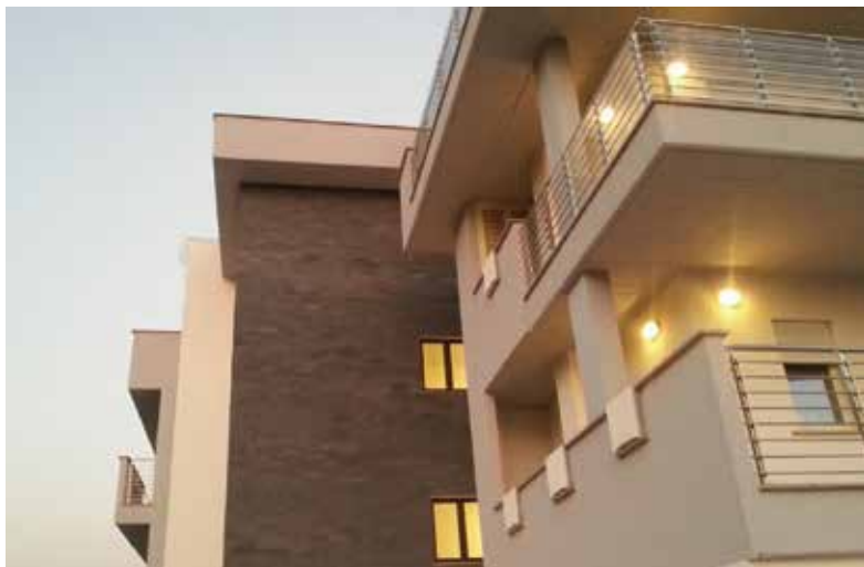
Cantiere anno 2017 zona Via della Pisana Rivestimento porzioni di facciata palazzina Via del Casale Ninfio Roma. Rivestimento QUARZITE colore Antracite
