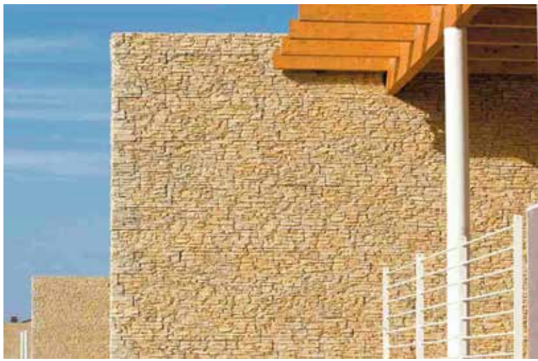
Cantiere anno 2007 zona Via di Vallerano Rivestimento setti di separazione ville bifamiliari Via Buster Keaton Roma. Rivestimento PETRA colore Giallosinai
